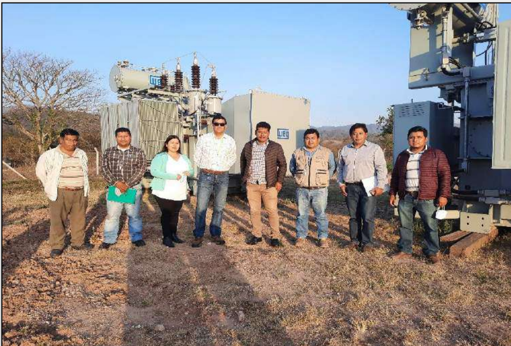
INSTALACION Y MONTAJES DE EQUIPOS EN LA SUBESTACION SAN MARTIN – CARAPARI- 69KV SUB ESTACION YAGUACUA
